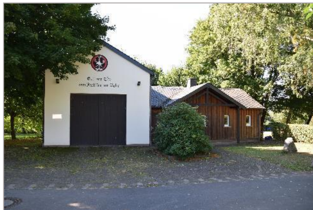
Bild 19: Feuerwehrgerätehaus (Quelle: Homepage Talling)
